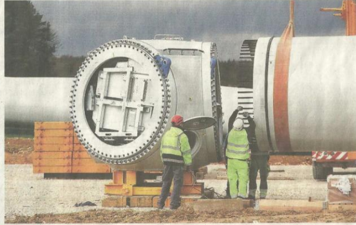
Im Inneren der Türme gibt es einen Aufzug (linkes Bild). Der Rotorstern – auf dem rechten Bild sieht man die Nabe – hat alleine einen Durchmesser von 117 Metern.
