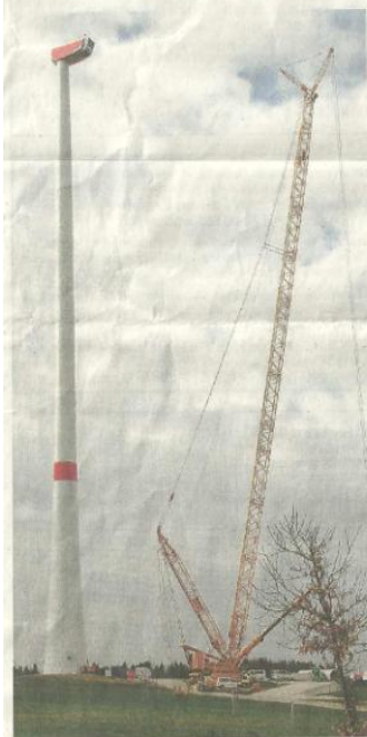
Für die Montage müssen Windgeschwindigkeiten von nicht mehr als sechs Metern in der Stunde herrschen.
